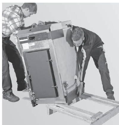
Fig. 13 Rimuovere la caldaia dal pallet
