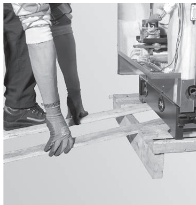
Fig. 11 Collocare le assi della gabbia a mo' di rampa
