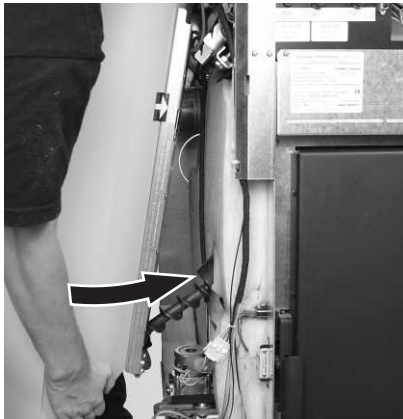
fig. 10 Infilare la coclea di alimentazione in basso accanto al tubo della coclea
