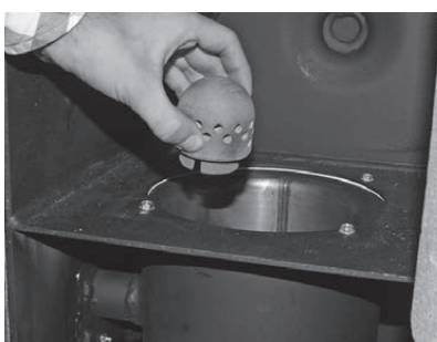
Fig. 59 Estrarre la spina aria primaria
