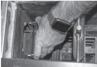
Fig. 71 Rimuovere il deflettore (solo per le caldaie a pellet con collettore di polveri elettrostatico)
