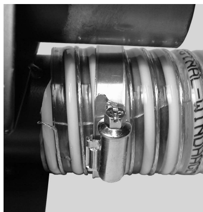
Fig. 9 Montaggio delle cravatte fermatubi
