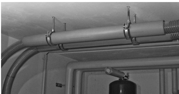
Fig. 7 Tubi flessibili di alimentazione nei tubi Polo-Kal
