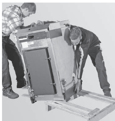
Fig. 11 Staccare la caldaia dal pallet
