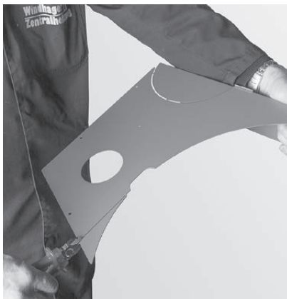
Fig. 80 Staccare con le tenaglie l'angolo del rivestimento sinistro superiore
