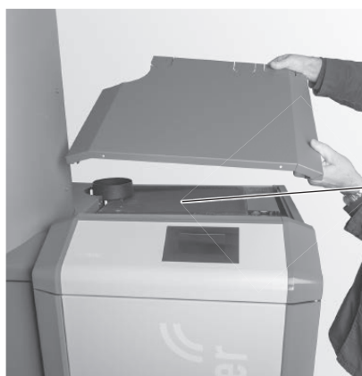
Fig. 139 Togliere il coperchio del rivestimento, rimuovere l'isolamento
