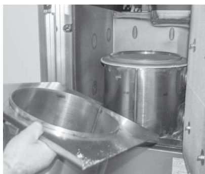
Fig. 65 Rimuovere il tubo della fiamma e pulire la camera di combustione
