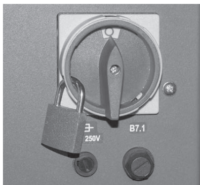
Fig. 3 Portare l'interruttore principale in posizione «0» e assicurarsi che non si riaccenda apponendo un lucchetto
