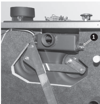
Fig. 16 Montaggio della guaina a immersione
