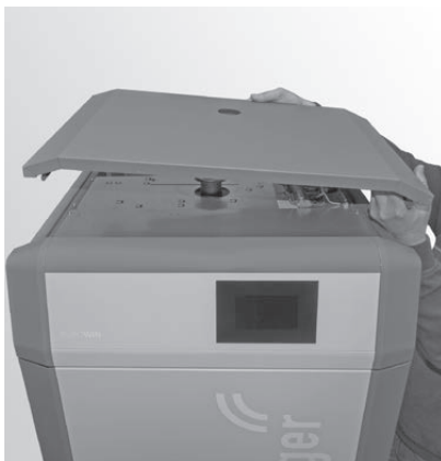
Fig. 95 Collocare la copertura anteriore e spingerla in avanti
