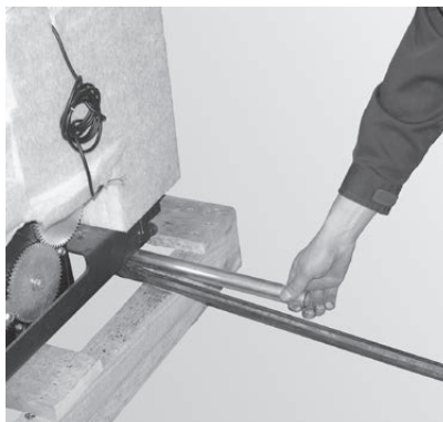
Fig. 9 Collocare la barra di ferro sotto la caldaia
