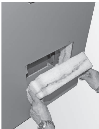
Fig. 53 Inserire l'isolamento in corrispondenza dell'apertura per la pulizia
