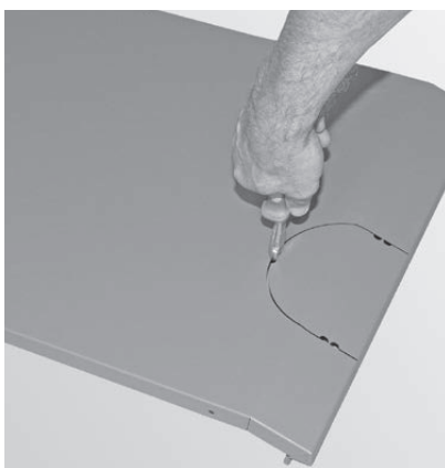
Fig. 97 Staccare la prepunzonatura nella copertura posteriore se il raccordo gas combusti è rivolto verso l'alto
