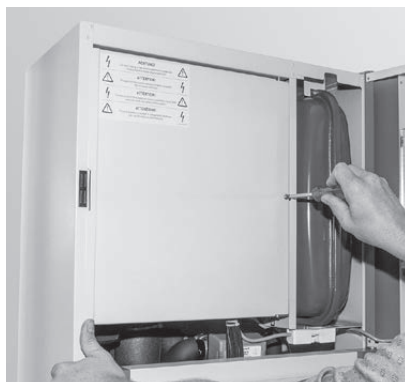
Fig. 17 Aprire la porta di contenimento e rimuovere la vite
