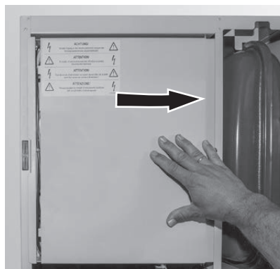
Fig. 18 Spingere la copertura verso destra e toglierla
