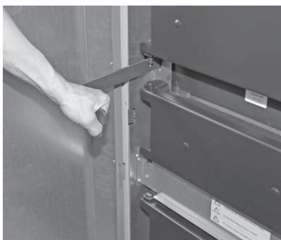
Fig.36 Azionare la leva di pulizia scambiatore per 5–10 volte
