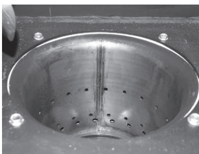
Fig. 77 Pulire i fori dell'aria secondaria nel corpo caldaia
