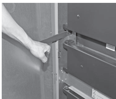
Fig. 18 Azionare la leva di pulizia scambiatore per 5–10 volte
