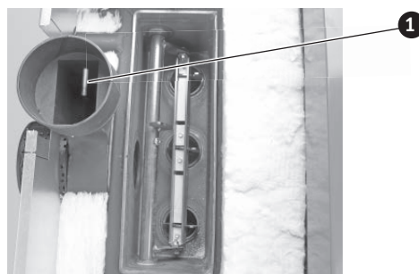
Fig. 46 Pulire le superfici riscaldanti superiori 1..... Sonda dei gas combusti (accessorio)
