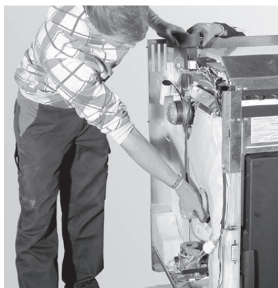
Fig. 14 Posizione della maniglia sul tubo della coclea e sul bocchettone dei gas combusti
