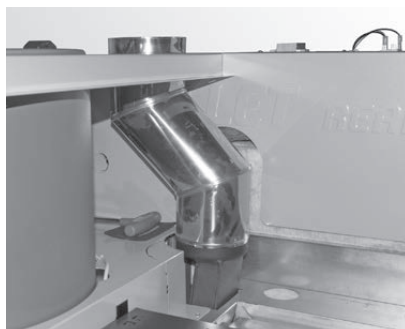
Fig. 157 Inserir il raccordo gas combusti
