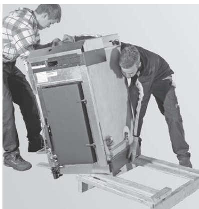
Fig. 15 Rimuovere la caldaia dal pallet
