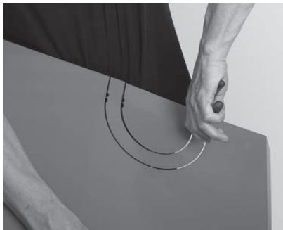
Fig. 141 Wenn kein Adapter für Abgasanschluss Se non si utilizza alcun adattatore per raccordo gas combusti, staccare la prepunzonatura verwendet wird, Vorstanzung ausbrechen
