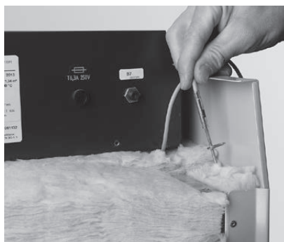
Fig. 67 Infilare la sonda Thermocontrol in alto
