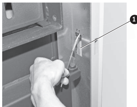
Fig. 68 Passare la sonda Thermocontrol 1.....Prepunzonatura – passaggio
