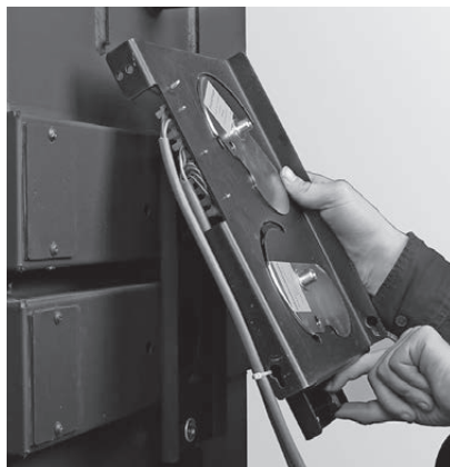
Fig. 44 Agganciare la regolazione aria in alto e avvitare sotto
