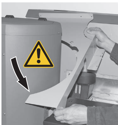
Fig. 121 Posare il rivestimento superiore con cautela
