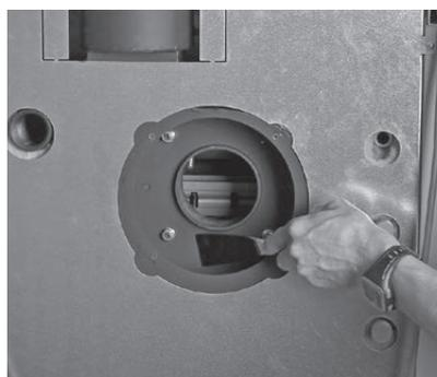
Fig. 37 Pulire l'interno della scatola del ventilatore
