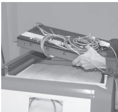
Fig. 47 Posare il quadro di comando sulla caldaia
