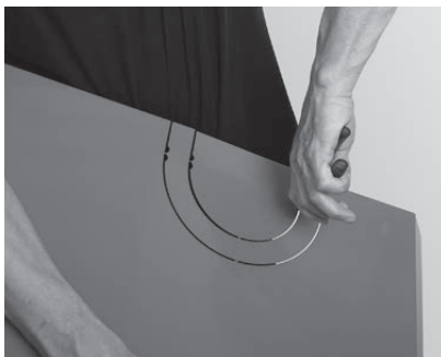
Fig. 79 Se non si utilizza alcun adattatore per raccordo gas combusti, staccare la prepunzonatura
