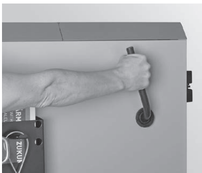
Fig. 39 Azionare la pulizia scambiatore a leva per circa 5 - 10 volte LogWIN Klassik
