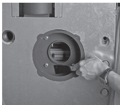
Fig. 60 Pulire l'interno della scatola del ventilatore
