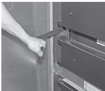
Fig. 40 Azionare la pulizia scambiatore a leva per circa 5 - 10 volte LogWIN Klassik pellet ready
