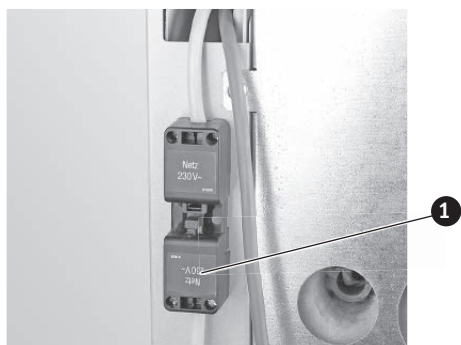
Fig. 57 Staccare la spina di rete 1.....Spina di rete
