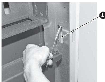
Fig. 55 Passare la sonda Thermocontrol
