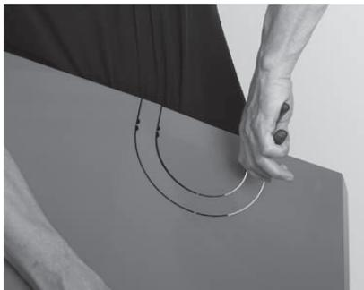
Fig. 80 Wenn **kein** Adapter für Abgasanschluss Se non si utilizza alcun adattatore per raccordo gas combusti, staccare la prepunzonatura verwendet wird, Vorstanzung ausbrechen
