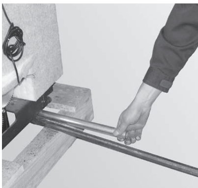
Fig. 8 Collocare la barra di ferro sotto la caldaia
